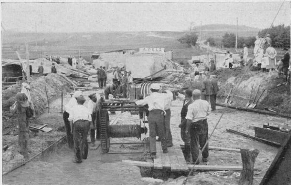
Abb. 14: Der Block wird durch Handwinden aus der Baugrube herausgezogen. — Erich Wohnsdorf, Königsberg i. Pr. phot.
