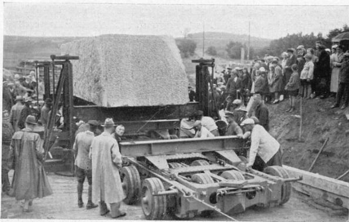
Abb. 16: Der Schwerlastwagen der Reichsbahn wird unter den gehobenen Block geschoben. — Erich Wohnsdorf, Königsberg i. Pr. phot.
