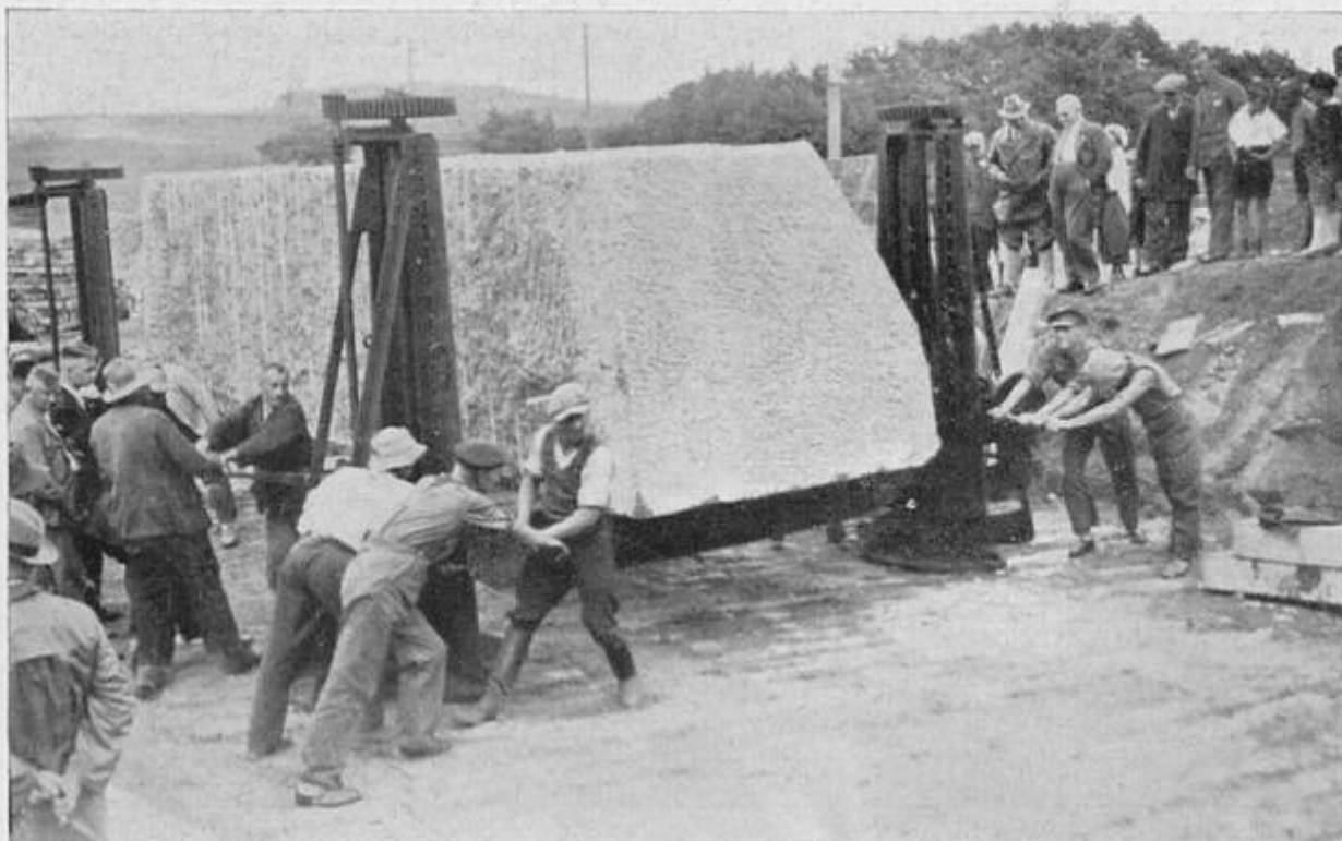
Abb. 15: Der Block wird mit vier Lokomotivhebewinden auf die Höhe des Transportwagens gehoben. — Erich Wohnsdorf, Königsberg i. Pr. phot.
