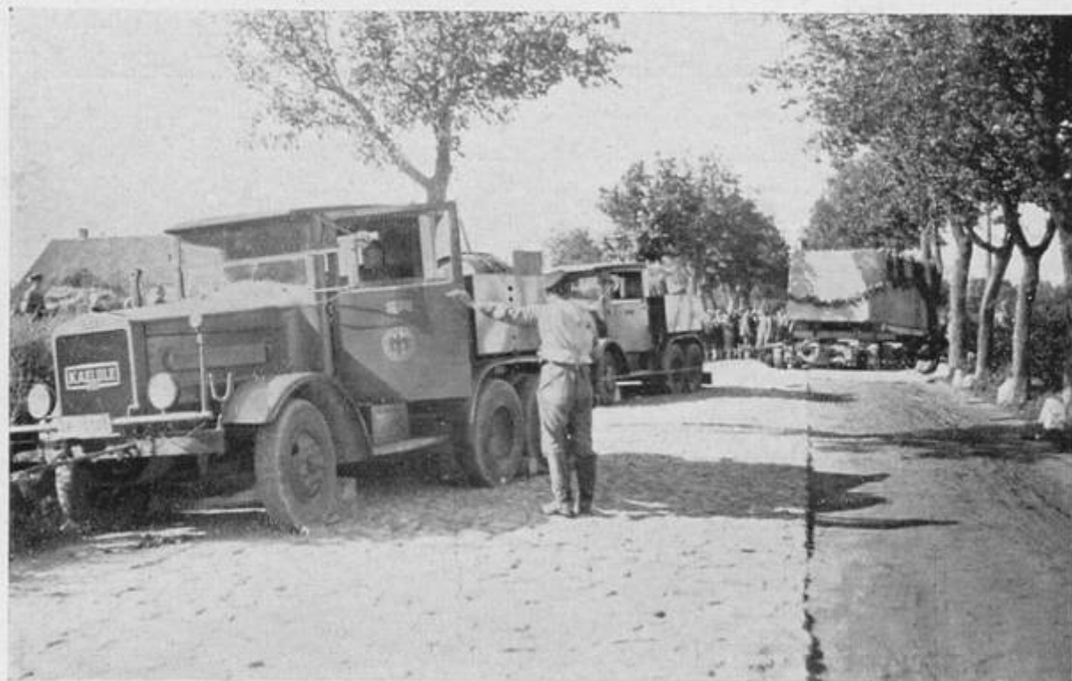
Abb. 18: Die beiden Motorschlepper der Reichsbahn winden den Block auf die Chaussee. — Erich Wohnsdorf, Königsberg i. Pr. phot.
