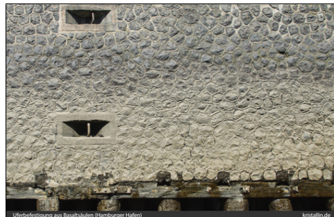
Bild 30 (links): Basaltsäulen als Baustein in einer alten Schleuse (Hamburger Hafen)
